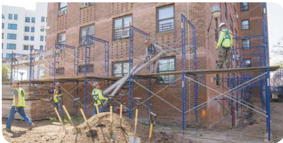
Hundiendo las palas: las obras de reconstrucción por los daños causados por Sandy están en marcha en el residencial de Coney Island Houses.
